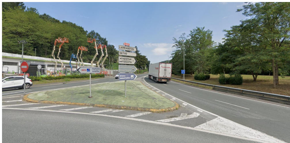
Inicio del tramo Rotonda de erletxes
